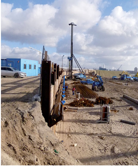
Bild 11 Herstellung der Teilverdrängungsbohrpfähle Production of the bore piles
